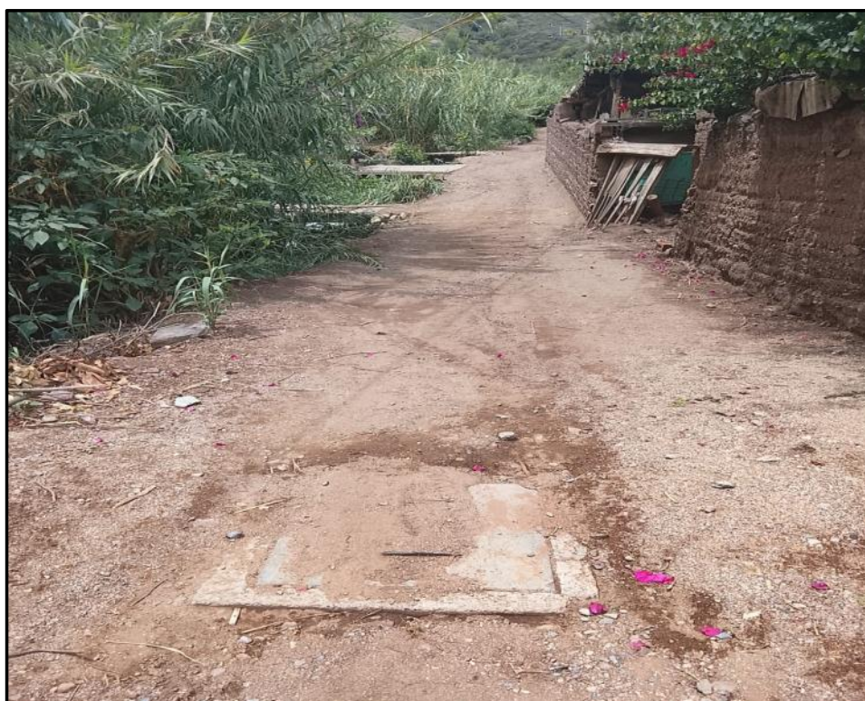
Fotografía N°02: Se observa una red de desagüe, la cual se encuentra vulnerable a la inundación.
