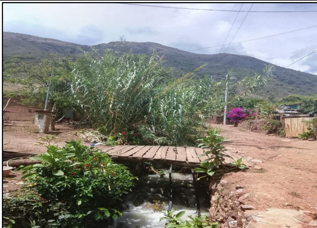
Fotografía N°02: Se observa que el puente peatonal de madera, se encuentra vulnerable a la erosión.
